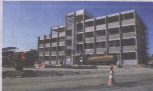
Em obras. Prédio que abrigará setor administrativo do porto, em dezembro
