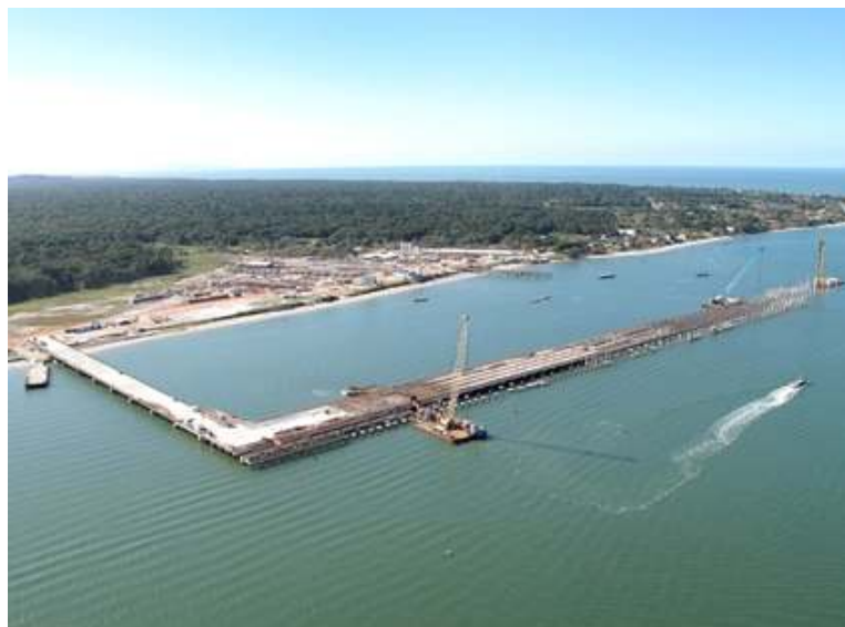
Obras do Tecon SC em Agosto 2009.
